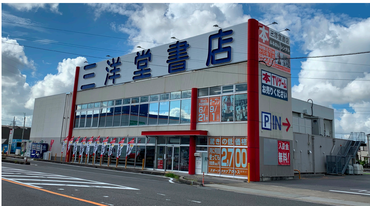
三洋堂書店知立店とスポーツクラブアクトス Will_G 三洋堂知立の外観
